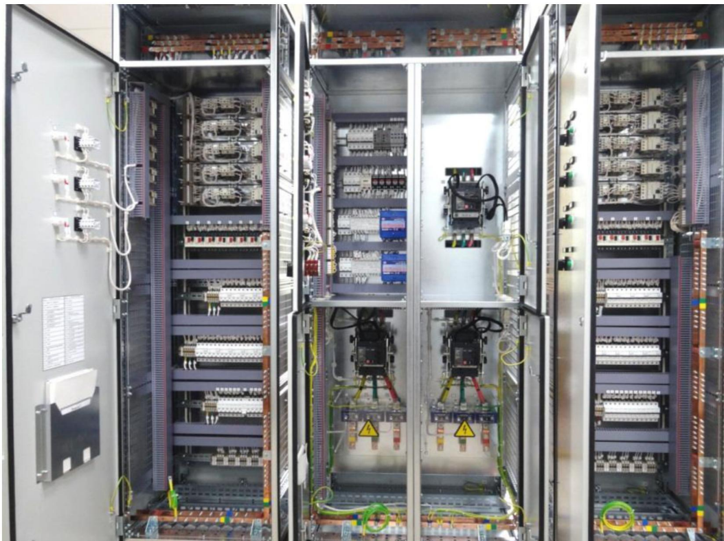
Рисунок 2.1 – Общий вид щитов «НКУ-BS-СТ»
